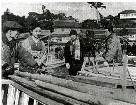
「縮図」の撮影現場で（左から筆者と乙羽信子）
